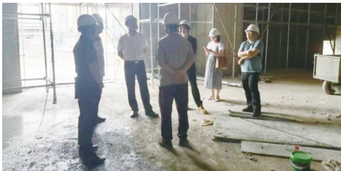
公司领导在项目现场检查安全措施
